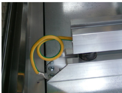
Cavallotto di terra su basamento ventilatore Earthing wire at fan base frame
