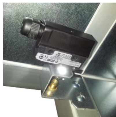
Microinterruttore ispezione ventilatore Microswitch fan's protection
