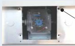
*All'interno del vano di passaggio cavi, sono montati anche i pressostati e le sonde che rilevano temperatura, umidità ecc. all'interno della centrale.*
