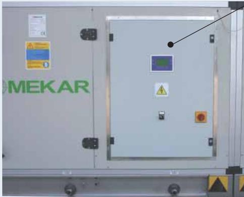
*Per le macchine da esterno il terminale è protetto da uno schermo in policarbonato IP55.
