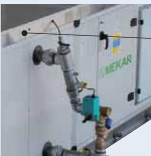
*I cavi sono stesi all'interno di un vano ricavato sopra la macchina. Lo speciale sistema di cablaggio, derivato dal campo automobilistico, permette una perfetta tenuta nel tempo, anche nelle UTA più esposte alle intemperie. Nel frequente caso di centrali fornite in più sezioni, le operazioni di cablaggio non richiedono più di due minuti.*
